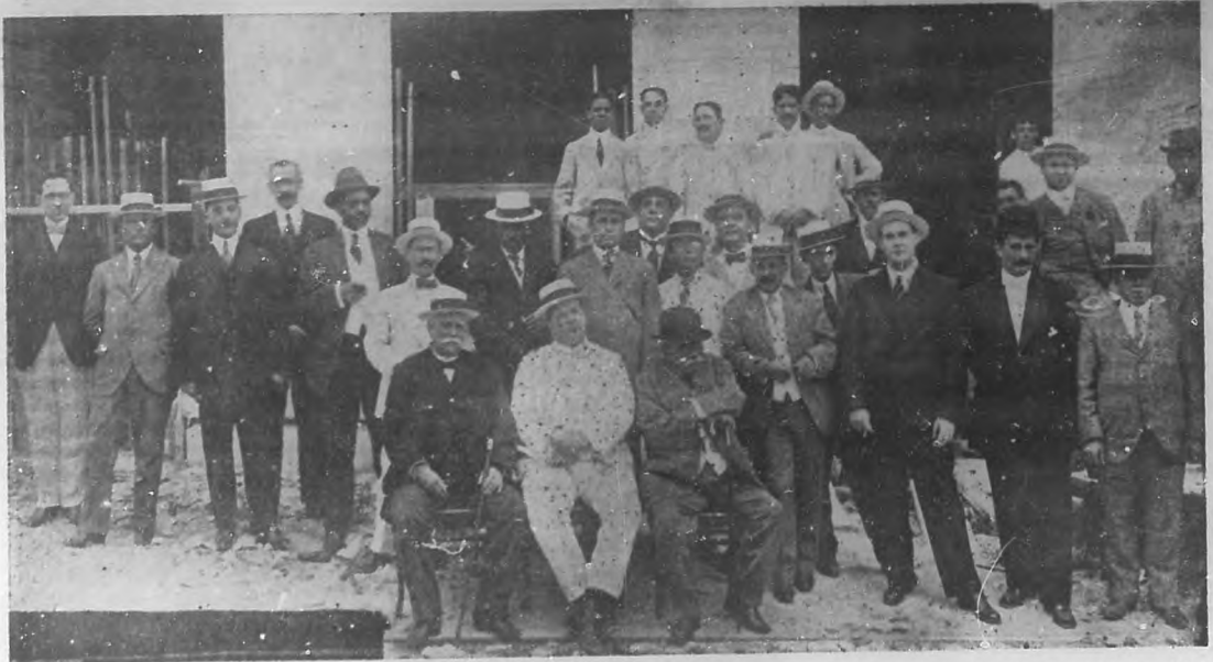
El Tercer Congreso de Consejeros de la República.—Momentos en que el Gobernador de la Provincia, acompañado de los Congresistas, visitó las obras del nuevo Palacio en construcción para el Gobierno Provincial. (Pot. de Feliú).
